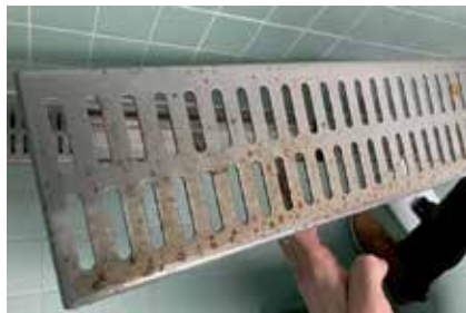
Korrosion an der Duschrinne ...
