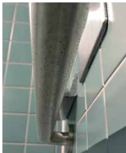
Korrosion an der Duschrinne ...
